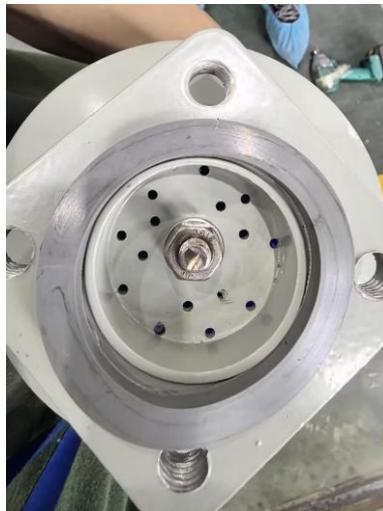
**Paso 4:** Instale el deshumidificador en el puerto del tubo de respiración, apriete los pernos en forma diagonal y coloque la junta de sellado según se muestra en la figura siguiente.
