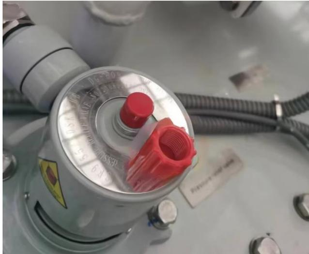
Figura 6-4 Cubierta de seguridad de la válvula de alivio de presión
