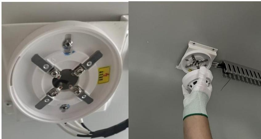
2. Inserte el nuevo sensor de humo en la base y gírelo en sentido horario hasta la posición de bloqueo.
