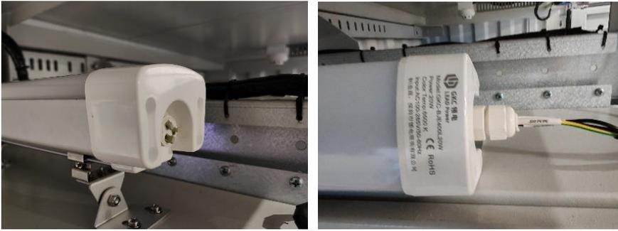
2. Retire los tornillos de fijación de la lámpara (pernos hexagonales externos M6) y retire la lámpara.
