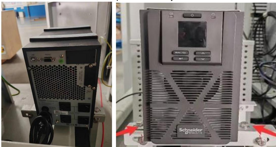
2. Retire el soporte de fijación del UPS y saque el UPS (perno M8 de cabeza semiredonda con cuello cuadrado).
