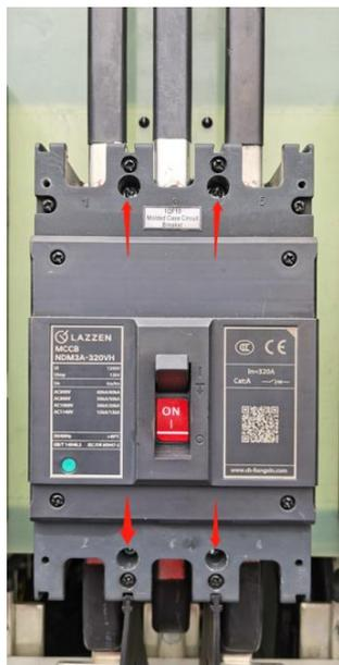
4. Sustituya por un nuevo interruptor automático en caja moldeada (MCCB), fíjelo en la placa de soporte y apriete.
