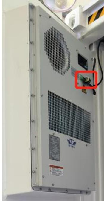
2. Retire un círculo de tornillos de fijación alrededor del aire acondicionado y retire el aire acondicionado (tornillos de cabeza hexagonal M5).
