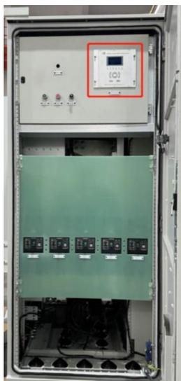
2. Abra el gabinete donde se encuentra el dispositivo, retire los cables en la parte trasera del dispositivo y marque su ubicación para registro; también puede retirar todos los terminales enchufables y colocarlos en la posición correspondiente del nuevo dispositivo.
