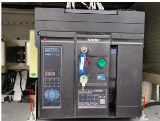
4. Reemplace con un nuevo Interruptor Automático de Aire y apriete los pernos de fijación inferiores.
